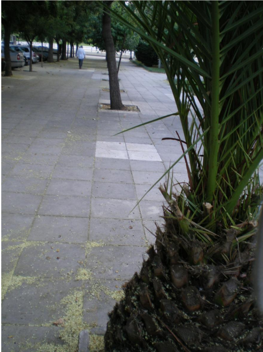
Οδός Φρειδεरिकού Σμιθ έξω από τα Δημοτικά Ιατρεία στο Δουργούτι. Οι διαφορετικού χρώματος πλάκες εμφανίζουν καθαρά το κενό που υπήρχε στην δεντροστοιχία.
